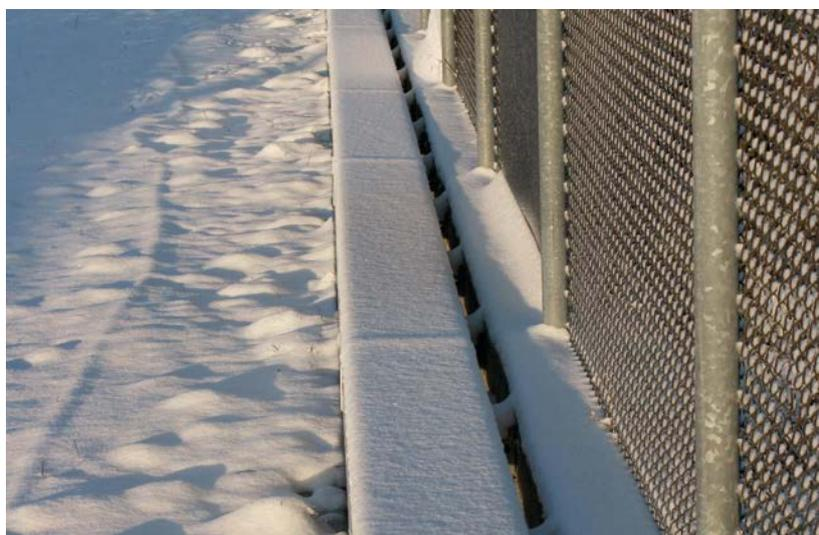
Le système de chemins de câbles isolants Unex est conçu pour absorber les dilatations de sa matière première. La distance "d" de séparation entre les dalles et entre les couvercles des chemins de câbles varie en fonction de la différence entre la température maximale et la température d'installation.
